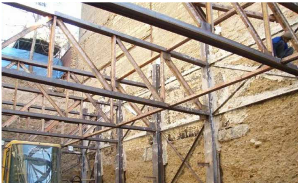
▲ شکل ۸: حفاظت ساختمان مجاور، همزمان با اجرای سازه نگهبان
