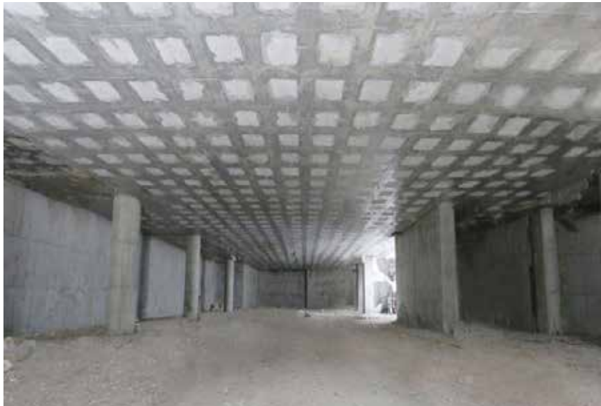
▲ شکل ۳: پروژه اجرا شده با سقف اینتل دک و حذف کامل تیرهای آویزدار میانی.
