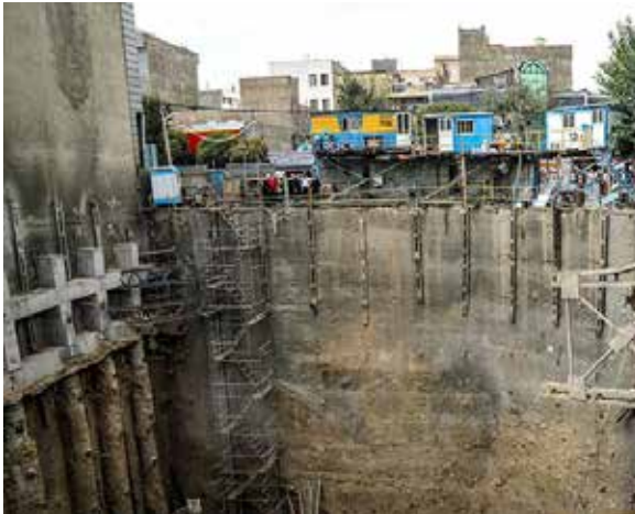
▲ شکل ۷: استقرار غیرایمن کانکس در مجاور گود
