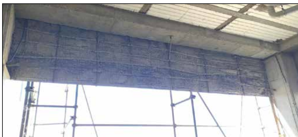
▲ عدم اجرای اصولی مهاربندی و اتصال پوسته نما به اسکلت ساختمان
