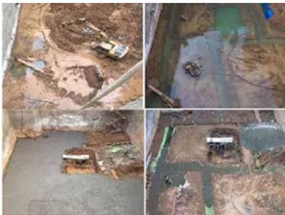
▲ شکل ۳: بالابودن سطح آب زیرزمینی در گود
