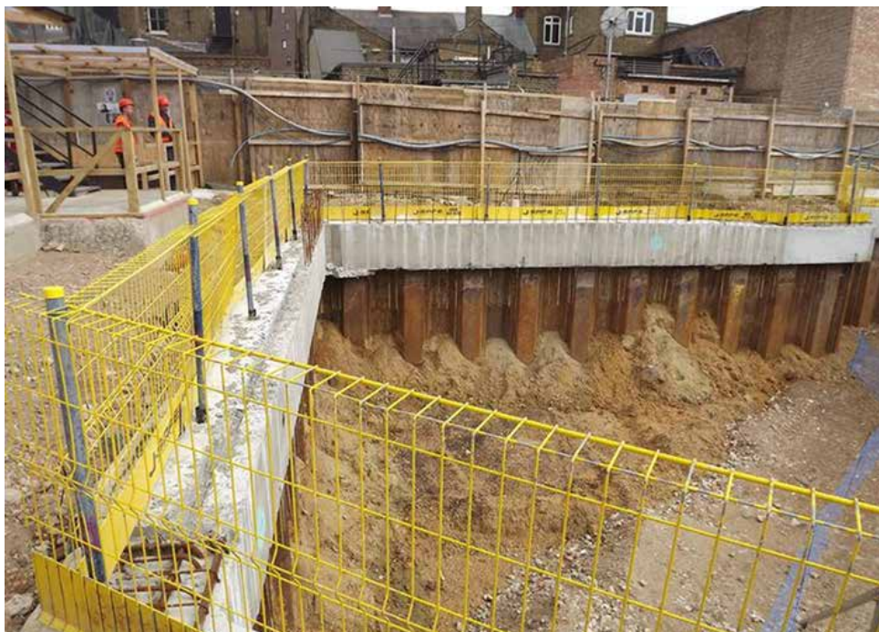
▲ شکل ۹: نرده حفاظتی در لبه گود برای پیشگیری از سقوط
