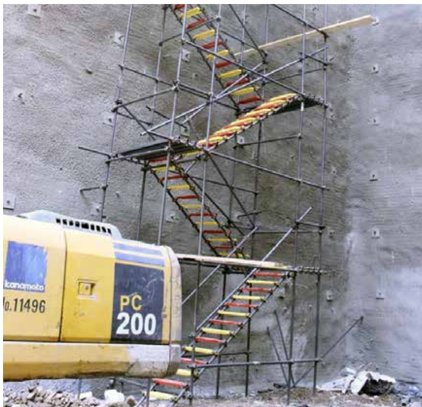
▲ شکل ۱۲: راه پله کارگاهی برای گودبرداری
