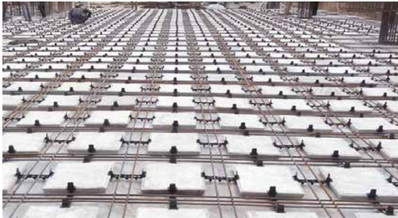
▲ شکل ۲: تصویر واقعی از نظم آرماتوربندی و فضای باز بین قالب‌ها.
