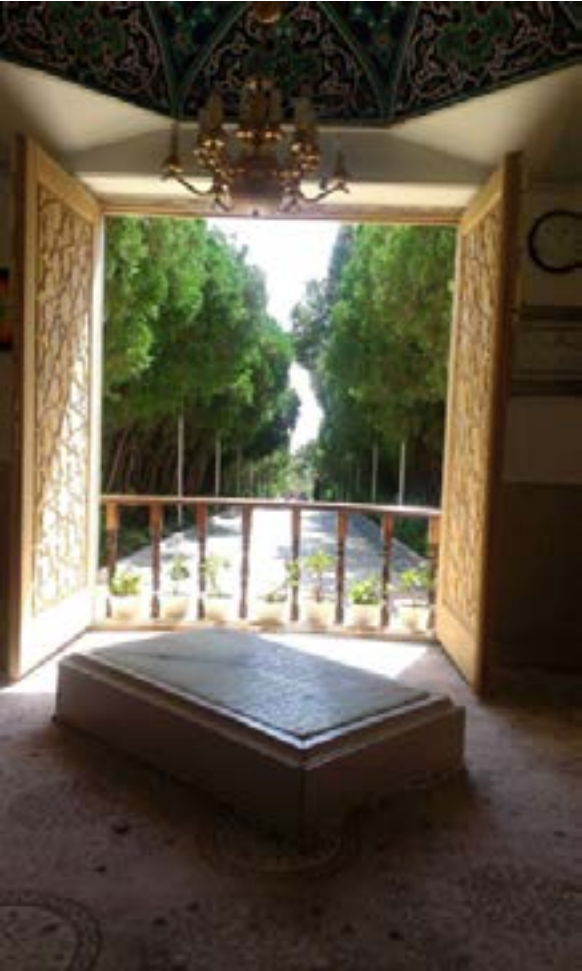
▲ شکل ۴- آرامگاه ابوالحسن خرقانی پس از مرمت
