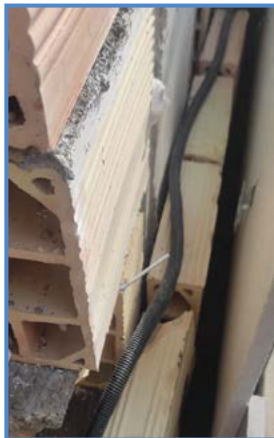
عدم اجرای شاسی کشی نما و استفاده نادرست از بلوک سفالی جهت پر کردن فواصل - استفاده از لوله خرطومی جهت نورپردازی
