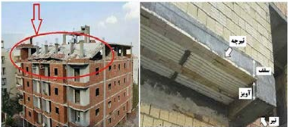
▲ شکل ۵- آویز در سقف تیرچه بلوک و برش پانچ
