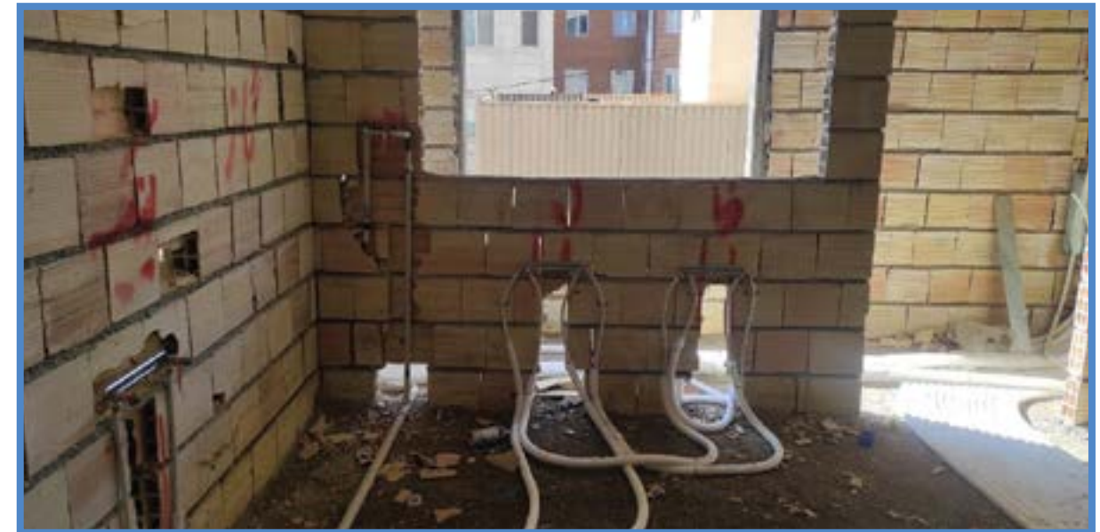
تخریب دیوارها در حین اجرای تأسیسات
