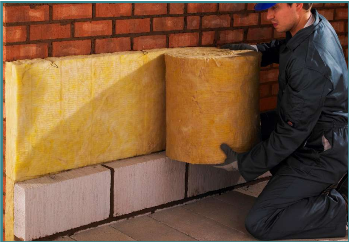
عایق کاری خارجی ساختمان با پشم سنگ رولی
