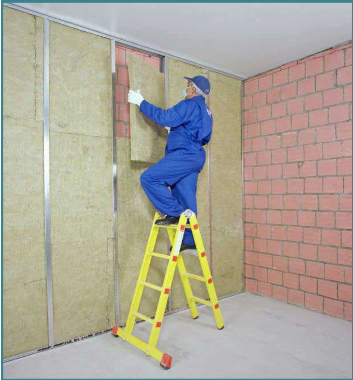
عایق کاری داخلی با پشم سنگ بتویی
