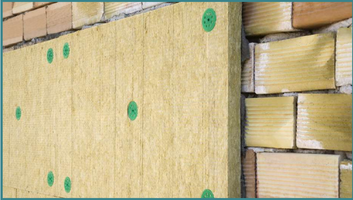
اجرای عایق کاری خارجی با پشم سنگ تخته ای و گل میخ
