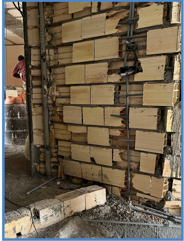
تخریب دیوارها جهت عبور لوله های تاسیسات
