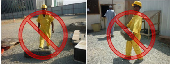
شکل ۶: جابجایی غیرایمن کپسول اکسیژن
