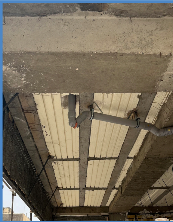
تخریب تیرچه جهت اجرای نگهدارنده لوله های فاضلاب
