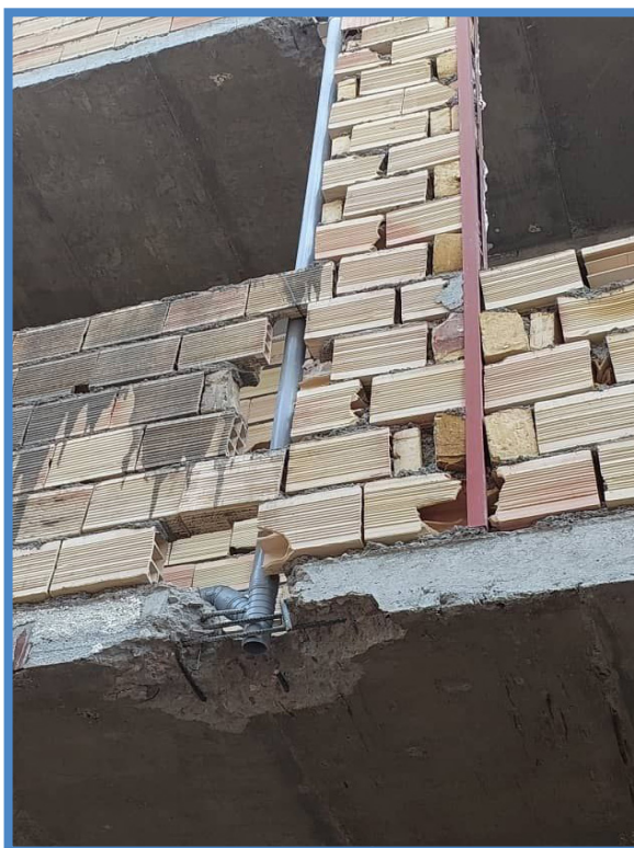
تخریب تیر بتنی جهت عبور لوله های تاسیسات
