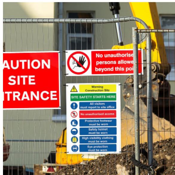
شکل ۳: نصب علائم هشداردهنده در کارگاه ساختمانی
