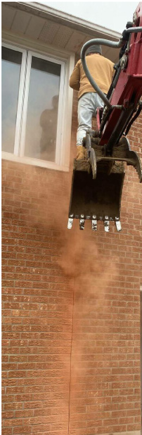
شکل ۳: استفاده غیر اصولی و غیر ایمن از ماشین آلات عمرانی
