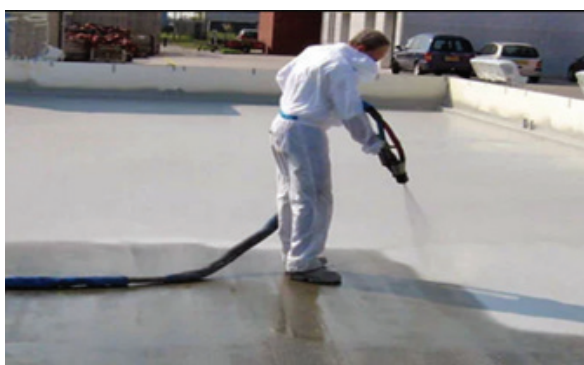
شکل ۳- نمونه‌ای از اجرای ماده غشاساز
