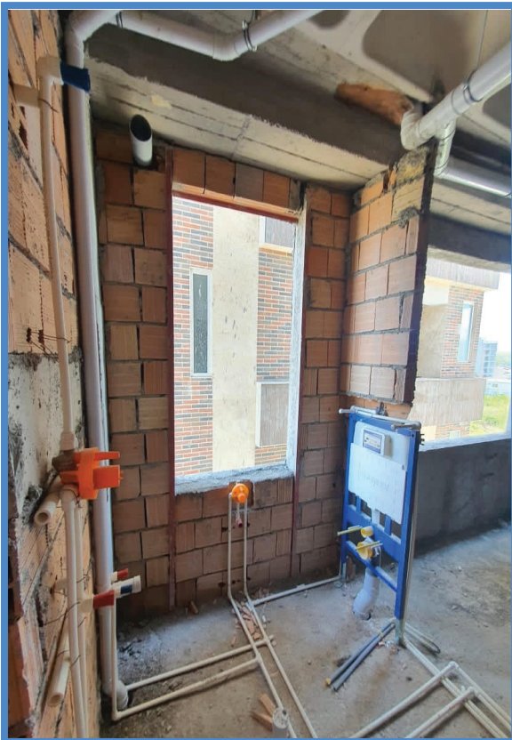
عدم اجرای داکت تاسیسات - تخریب تیرهای بتنی سقف جهت عبور لوله ها - تخریب دیوارها جهت اجرای لوله های تاسیسات - عدم اجرای اصولی وال هنگ
