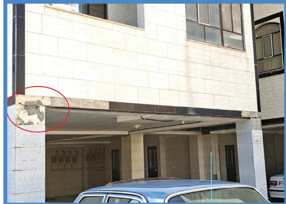
استفاده غیرمجاز از سرامیک به عنوان متریل نمای خارجی - عدم اسکوپ سنگ نما
