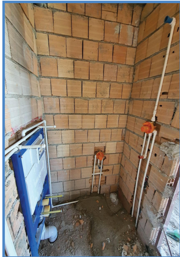
عدم اجرای داکت تاسیسات - تخریب تیرهای بتنی سقف جهت عبور لوله ها - تخریب دیوارها جهت اجرای لوله های تاسیسات - عدم اجرای اصولی وال هنگ
