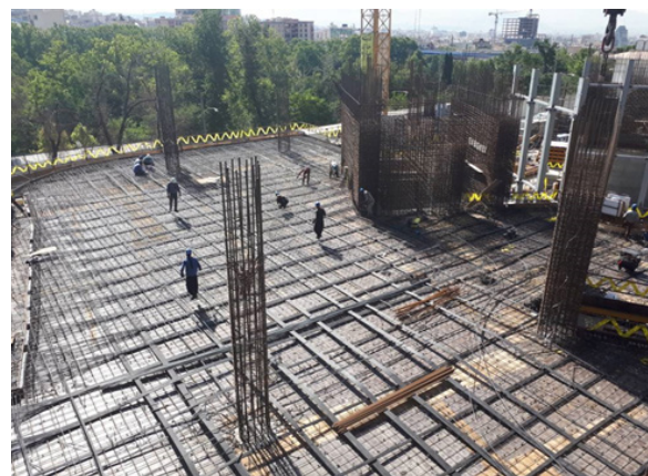
شکل ۱۰: سقف پیش‌تنیده استفاده شده در پارکینگ
