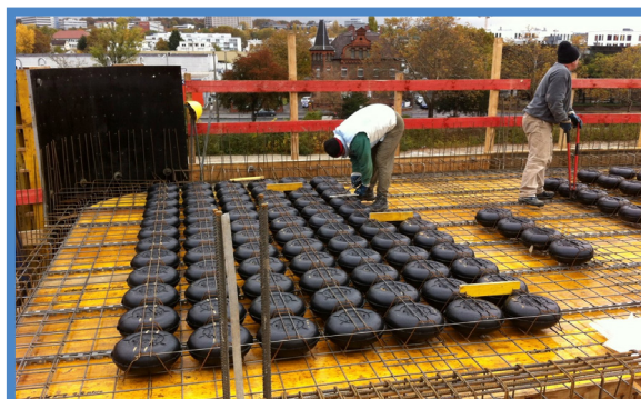
اجرای ساختمان به روش سیستم سازه ای کوبیاکس
