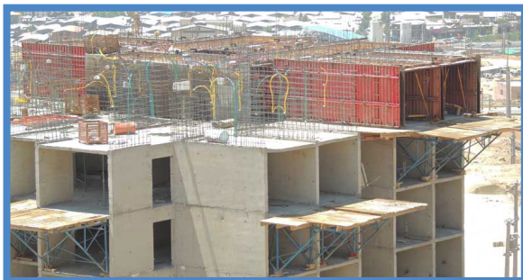
اجرای ساختمان به روش سیستم سازه ای قالب تونلی
