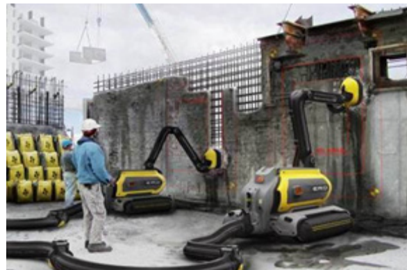
شکل ۵- ربات در ساخت و ساز
