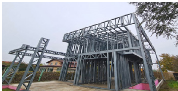
شکل ۱۵- سیستم سازه سبک فلزی [۱۶]
