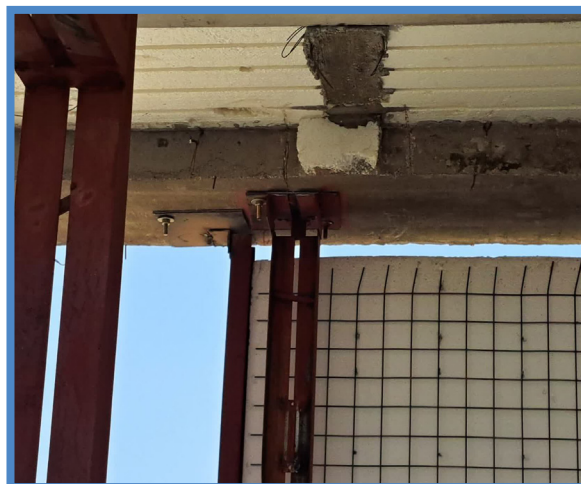
فناوری دیوارهای پیش ساخته 3D Panel
