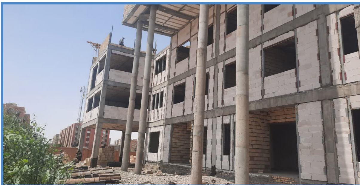
فناوری دیوارهای پیش ساخته 3D Panel
