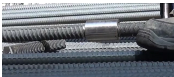
شکل ۱۱: وصله مکانیکی آرماتور فونداسیون
