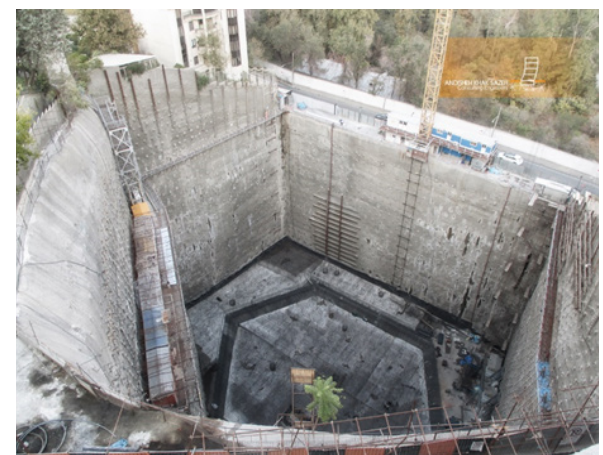
شکل ۳: اجرای بی ساختمان
