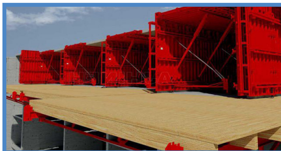
اجرای ساختمان به روش سیستم سازه ای قالب تونلی
