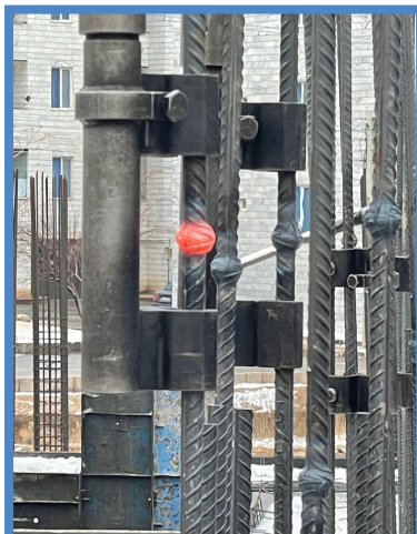
عملیات جوش فورجینگ جهت کاهش پرت میلگردها
