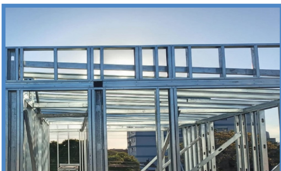
اجرای ساختمان با سیستم سازه ای LSF
