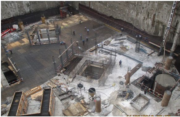
شکل ۱۲: محل احداث بچینگ بر روی فونداسیون
