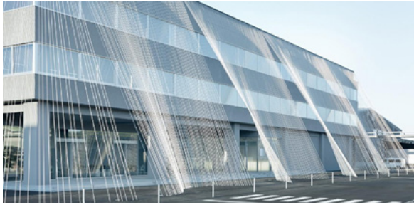
شکل ۱۱- میله‌های رشته‌ای در ساختمان
