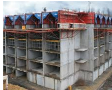
شکل ۹- ساختمان با سیستم قالب تونلی [۳]
