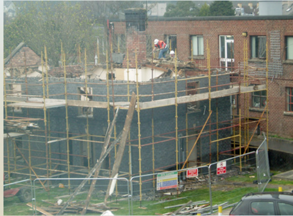
شکل ۴: تخریب دیوار نازک با داربست
