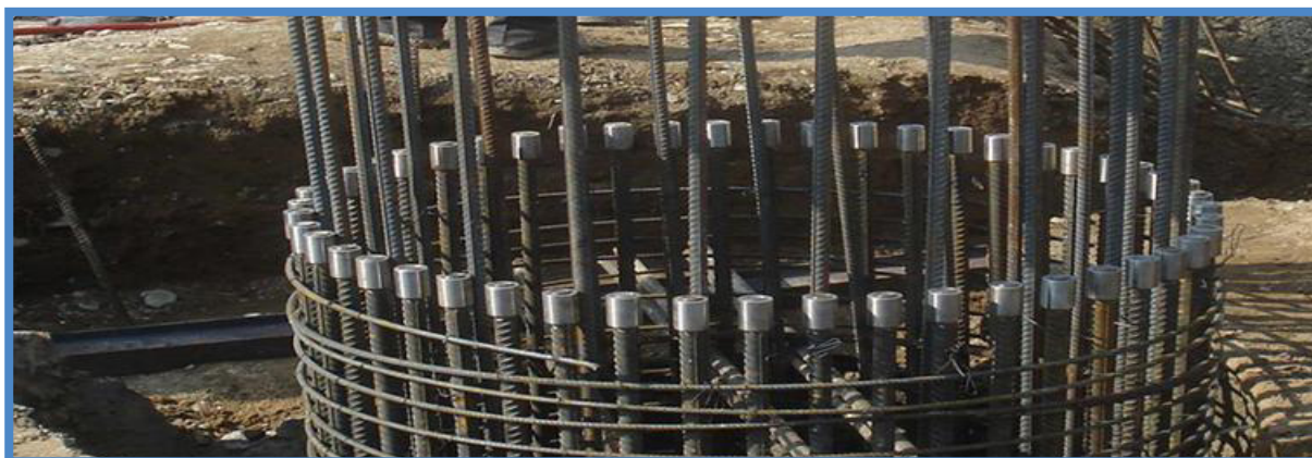
عملیات کویلینگ جهت کاهش پرت میلگردها
