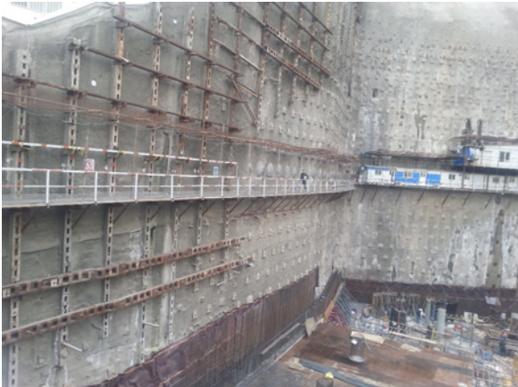
شکل ۳: ج- نیل و انکر به کاررفته برای پایدارسازی گود
