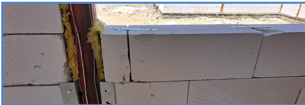
استفاده از بلوک های عایق AAC
