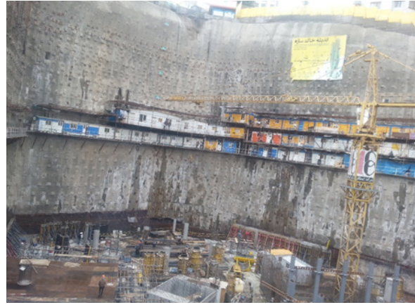
شکل ۳: ب- نیل و انکر به کاررفته برای پایدارسازی گود
