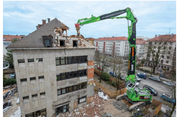
شکل ۱: تخریب ایمن - تخریب از بالا به پایین
