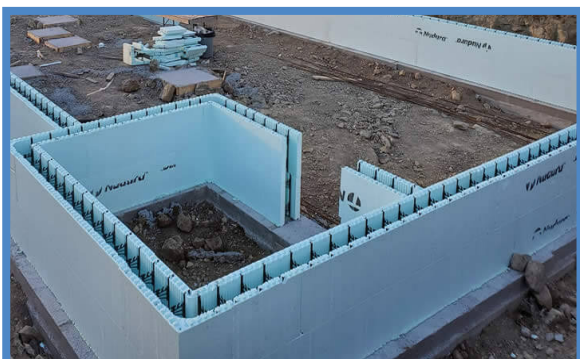
اجرای ساختمان با سیستم سازه ای ICF (قالب عایق ماندگار)
