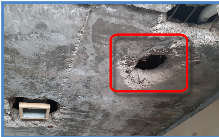
تخریب سقف جهت عبور تاسیسات
