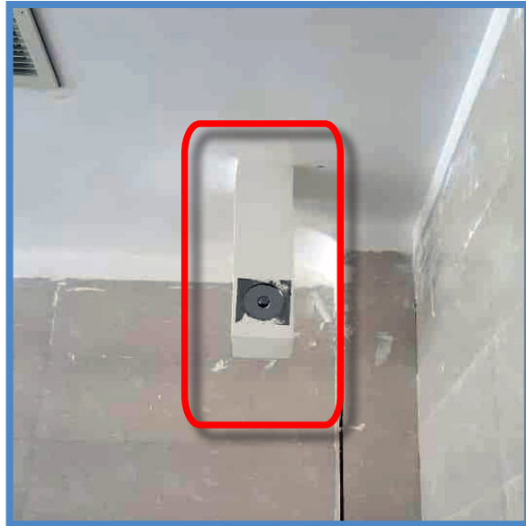
اجرای غیر اصولی و نامناسب دودکش بخاری
