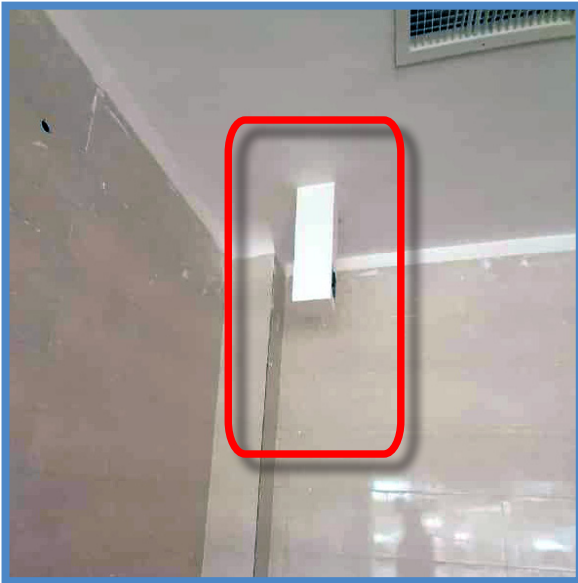
اجرای غیر اصولی و نامناسب دودکش بخاری
