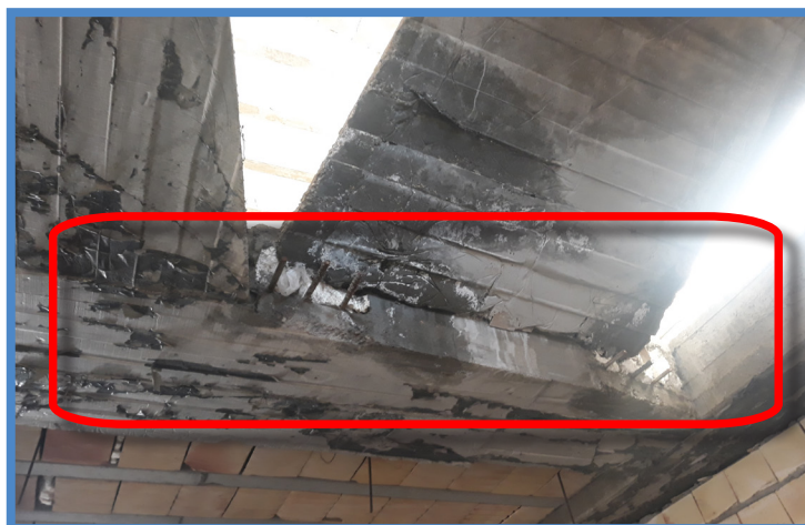
عدم اجرای صحیح رمپ پله با توجه به میلگردهای انتظار
