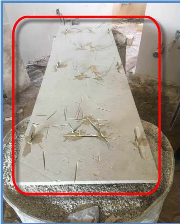
اجرای غیر اصولی اسکوپ سنگ بواسطه تخریب بیش از حد جرم سنگ
