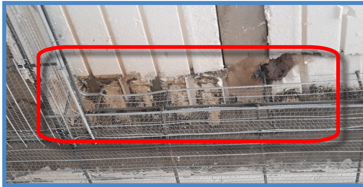
تخریب تیرچه ها جهت گرفتن میلگرد های ساپورت سقف کاذب
