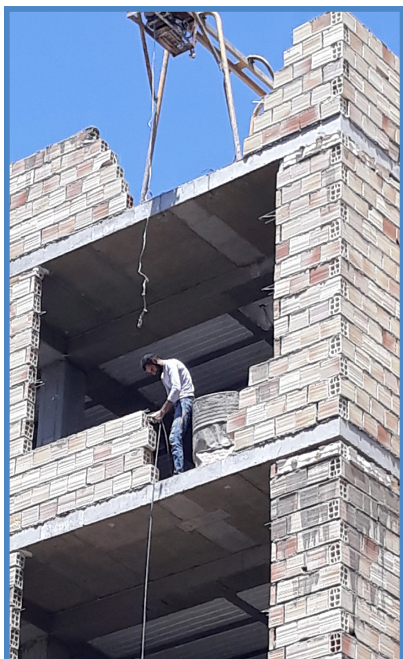
عدم اجرای وال پست دیوارهای خارجی - عدم اجرای نرده یا حصار موقت جهت جلوگیری از سقوط افراد
