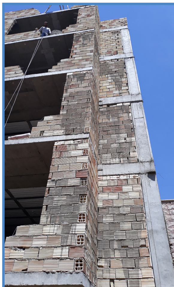
عدم اجرای وال پست دیوارهای خارجی - عدم اجرای نرده یا حصار موقت جهت جلوگیری از سقوط افراد
