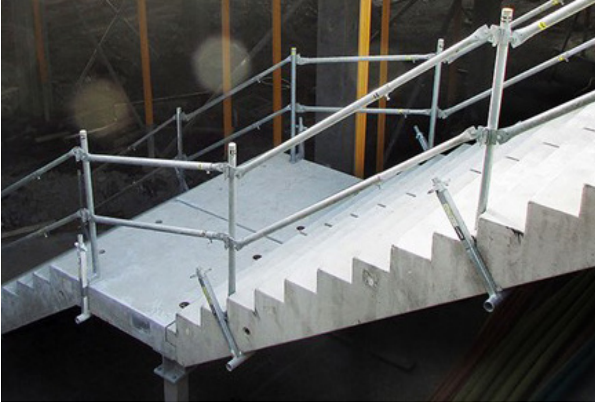
شکل ۲: استفاده از داربست برای حفاظت کاری لبه پرنگاه در راه پله
