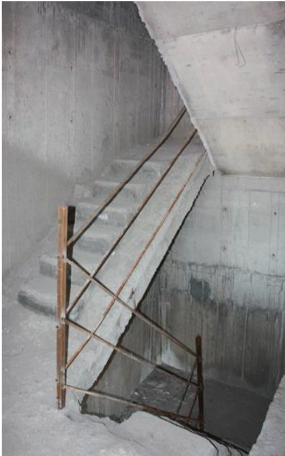
شکل ۱: نصب نرده حفاظتی موقت در لبه پرتگاه ساختمانی
