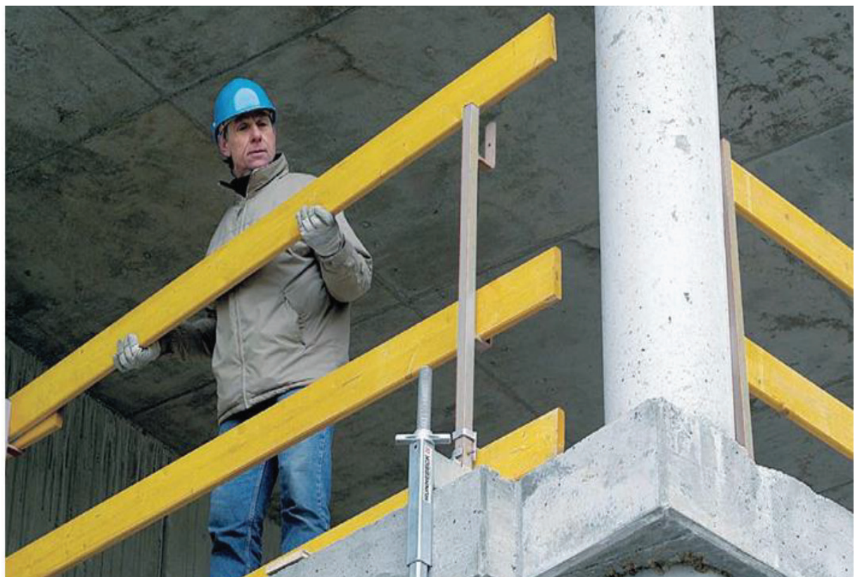
شکل ۲: نصب نرده حفاظتی موقت در لبه پرتگاه ساختمانی
