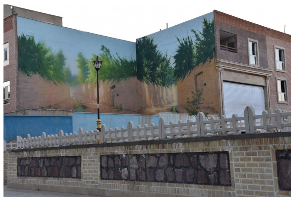
شکل ۵. اجرای نقاشی منظره روی جداره بدون نمای مشرف به معبر توسط شهرداری منطقه یک
