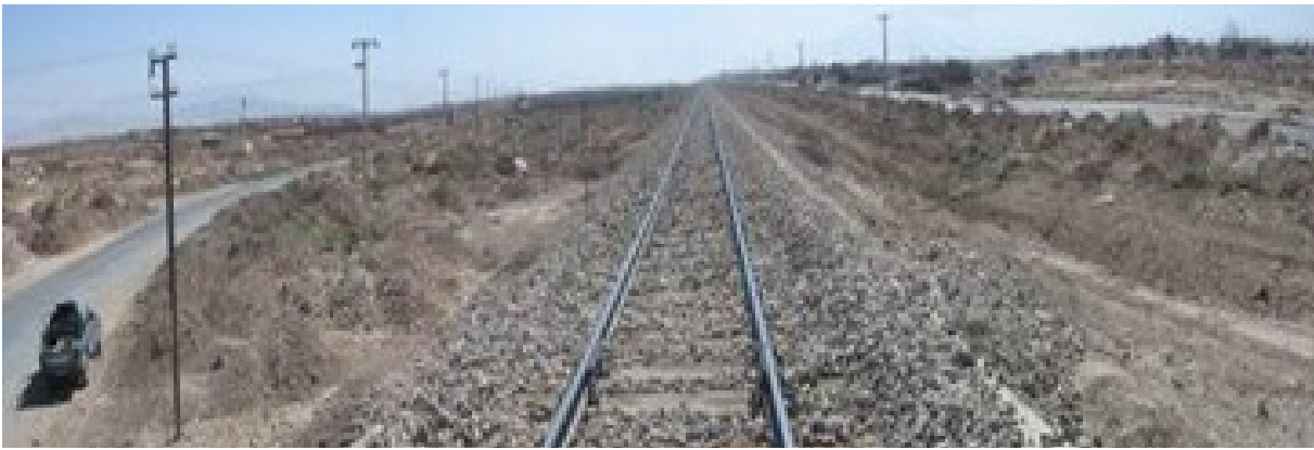
شکل ۳- تخلیه ضایعات ساختمانی در کنار ریل راه آهن
