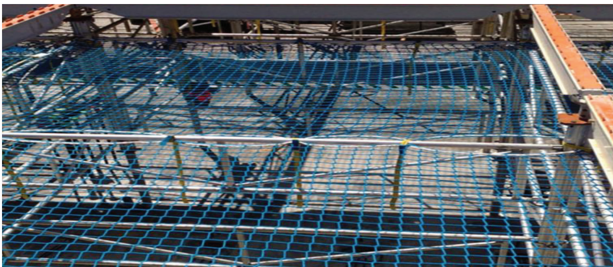
شکل ۹: اجرای سامانه متوقف کننده سقوط در زمان اجرای سقف بتنی
