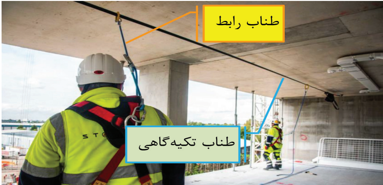
شکل ۴: اجرای سامانه محدود کننده سقوط به شکل فردی
