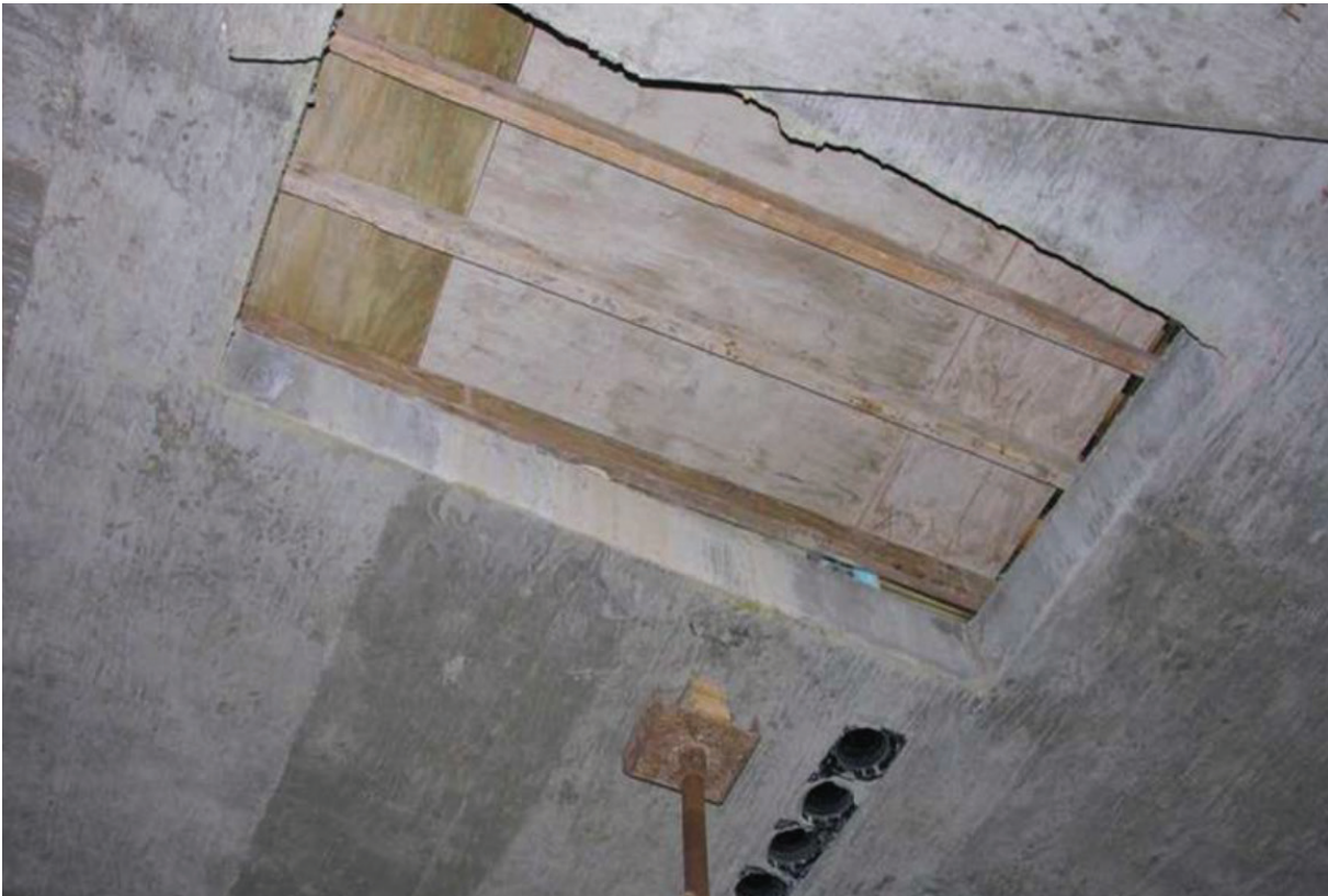
شکل ۳: اجرای پوشش موقت بر روی دهانه باز (عکس از زیر سقف برداشته شده است)
