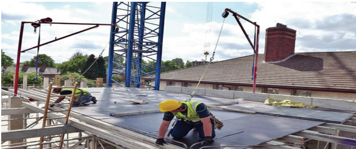
شکل ۸: نصب توری حفاظتی در کارگاه حفاظتی
