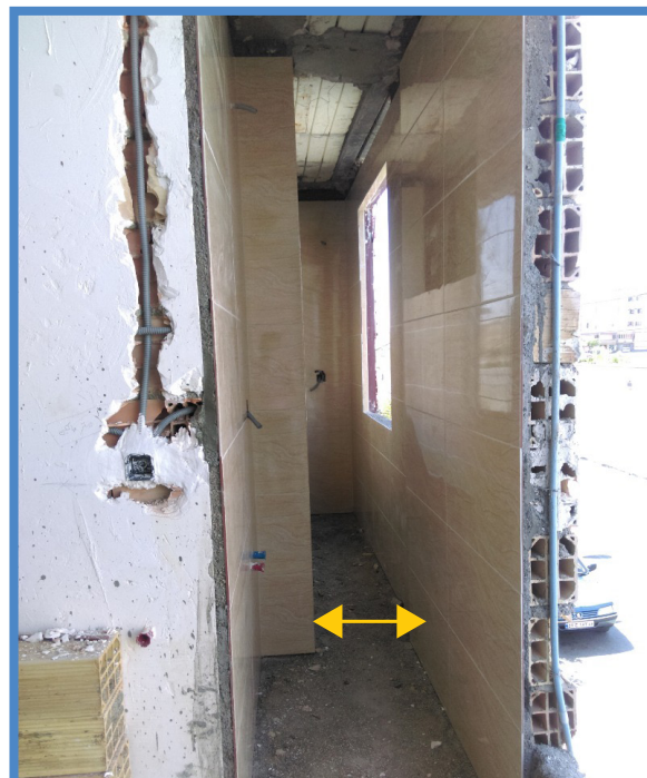
۵. طراحی غیر اصولی و نهایتاً اجرای نامناسب، عرض بالکن به ۵۶ سانتی متر تقلیل یافته
