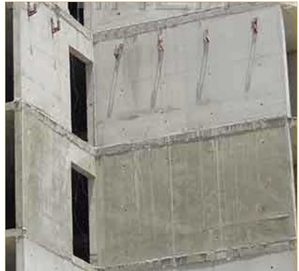
شکل ۳-۲ نمای دیوار بتنی
