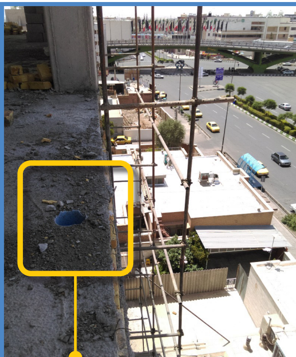
۶. تعبیه لوله PVC در تیر بتنی جهت عبور تاسیسات با توجه به عدم لحاظ شدن در محاسبات
