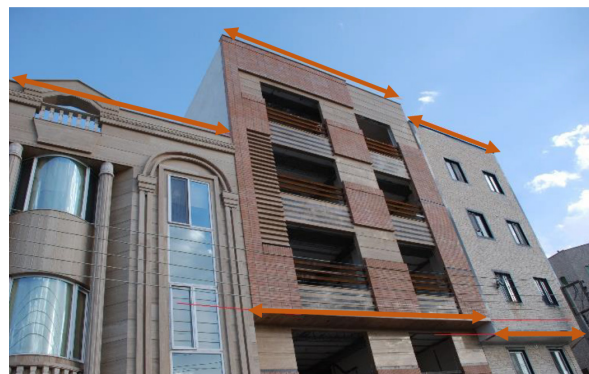
شکل ۶. رعایت نکردن طراحی میان‌افزا (هیچ‌گونه هماهنگی‌ای در بدنه مشاهده نمی‌شود)
