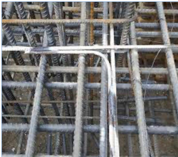
جوشکاری هادی هم بندی در گوشه ها
