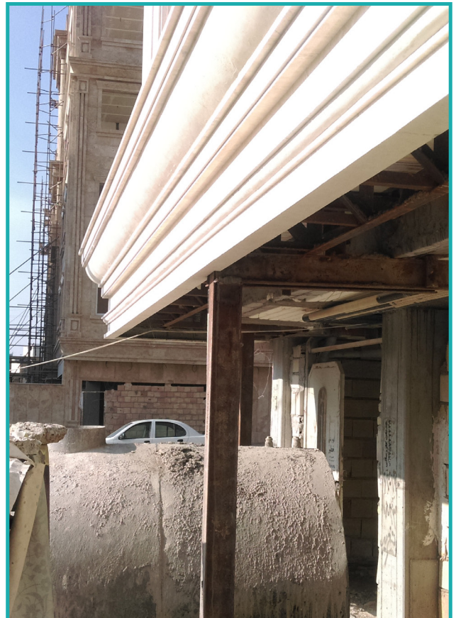
اجرای غیر اصولی نما خارج از محدوده مجاز، عدم محاسبه وزن بیش از حد نما و مهار بار اضافی بواسطه ستون فلزی
