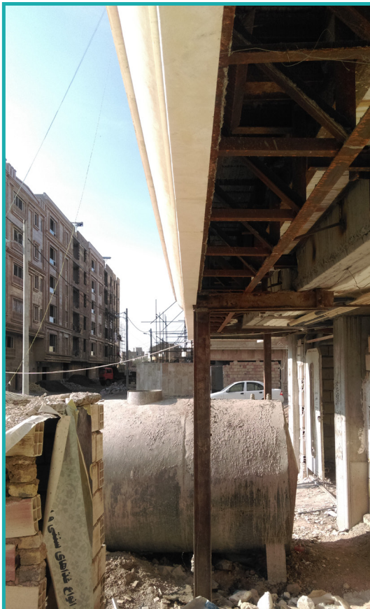
اجرای غیر اصولی نما خارج از محدوده مجاز، عدم محاسبه وزن بیش از حد نما و مهار بار اضافی بواسطه ستون فلزی
