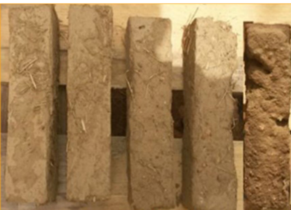
شکل ۳-۲ نمای دیوار کاهگلی
