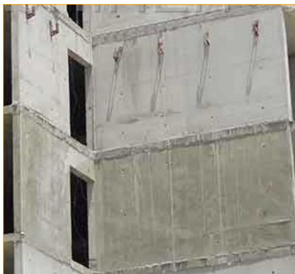
شکل ۳-۲ نمای دیوار بتنی
