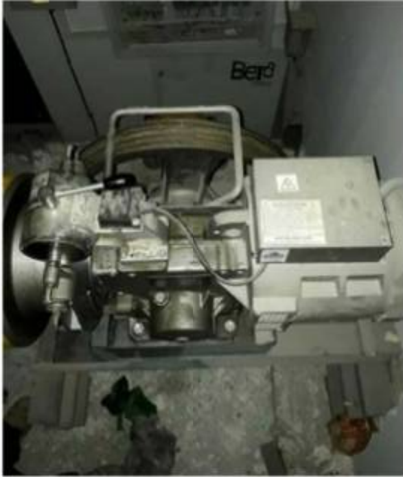
نشست و اسکاژین از همه قسمت‌های موتور به دلیل بی‌توجهی سرویس کار آسانسور
