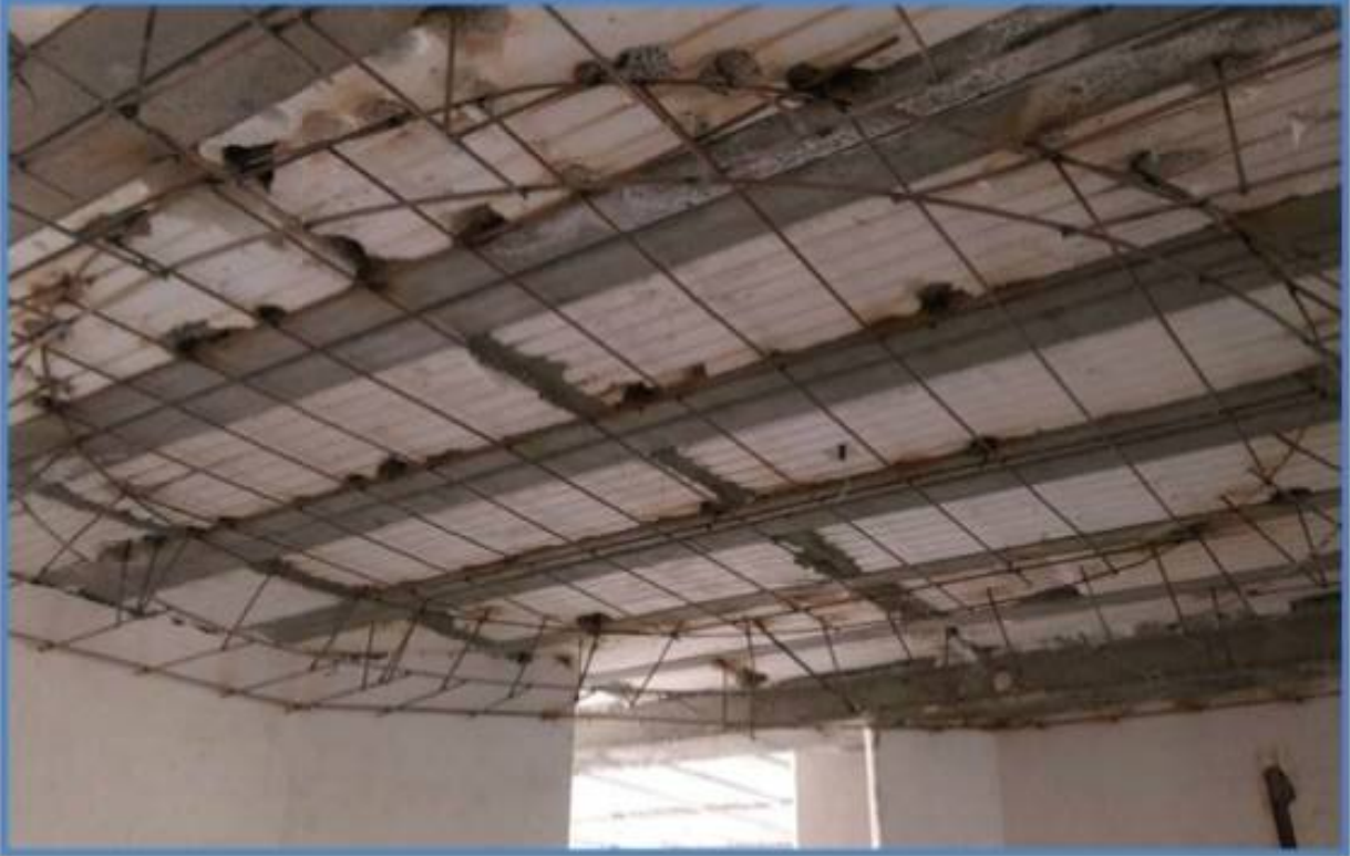
۳. تخریب بتن پاشنه تیرچه جهت اجرای ساپورت سقف کاذب
