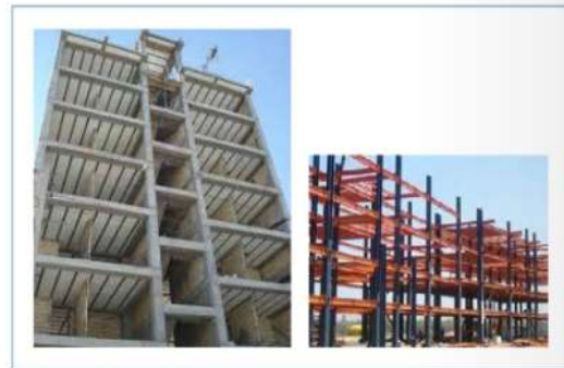
تصویر ۱ نمونه‌هایی از ساختمان‌های بتنی و فولادی
