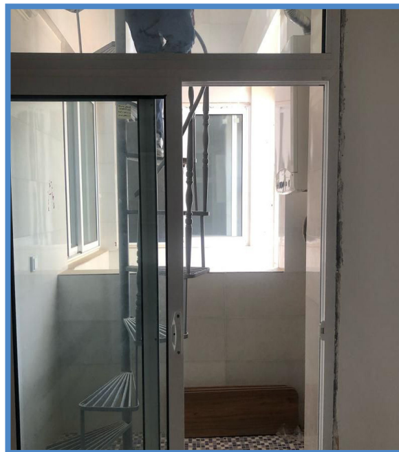
عدم رعایت اصول فنی پلکان از داخل نورگیر به بام (اتصال به ستون بتنی)
